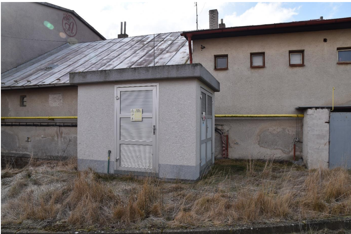
Vlastní trafostanice v areálu.
